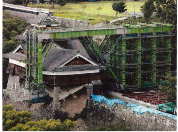
写真2 隅石だけで持ち堪えた飯田丸五階櫓
