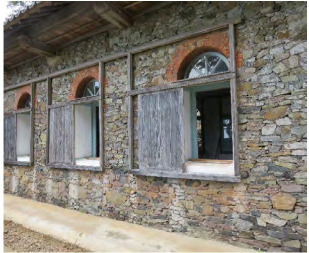
ド・ロ壁と窓のレンガアーチ
